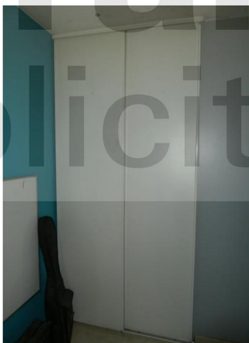
Le pan de mur de droite accueille un placard encastré ouvrant à deux portes coulissantes en bois mélaminé, fixées sur rails métalliques.
