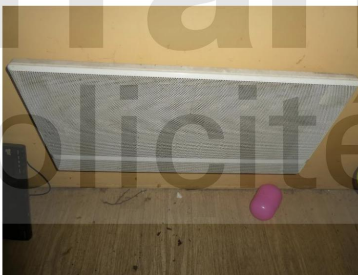
En allège de la fenêtre, un convecteur électrique avec panneau rayonnant.
