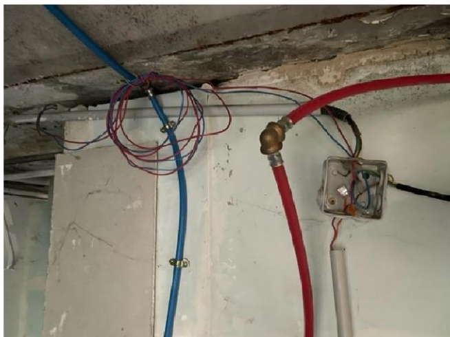
B.8.3 e) : Au moins un conducteur isolé n'est pas placé sur toute sa longueur dans un conduit, une goulotte, une plinthe ou une huisserie, en matière isolante ou métallique, jusqu'à sa pénétration dans le matériel électrique qu'il alimente.
