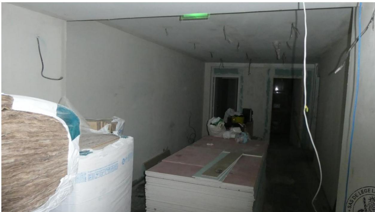
17 L'ensemble est en cours de travaux
