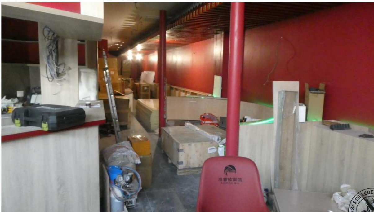
9 Côté salle de restaurant
