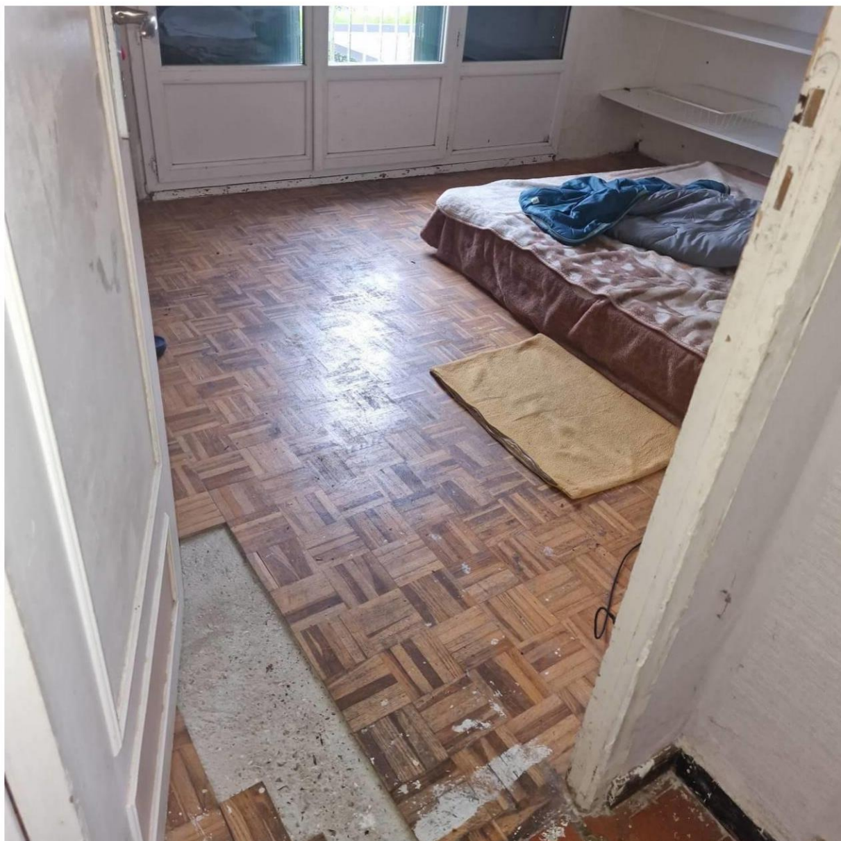
Chambre sur rue
