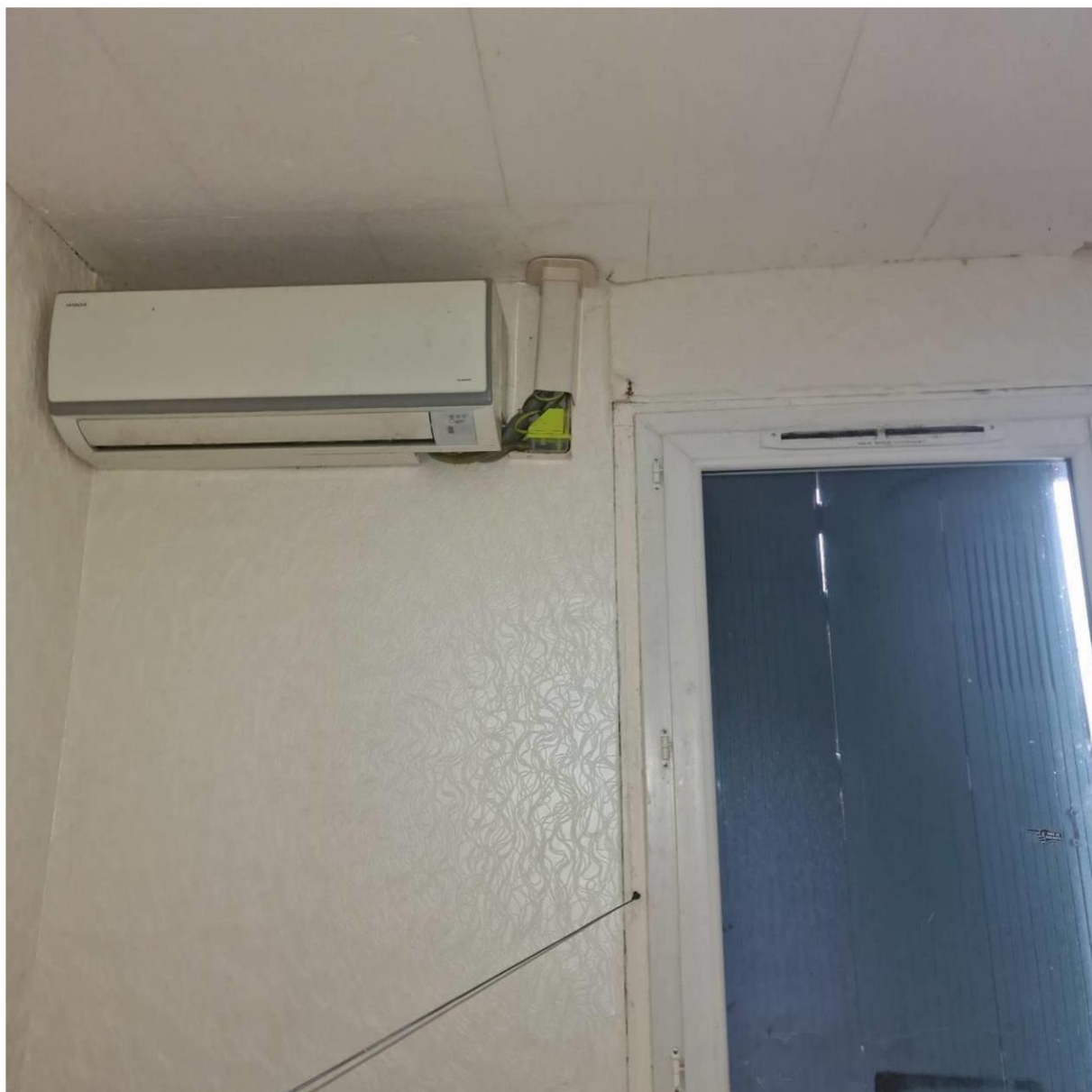
Chambre sur rue
