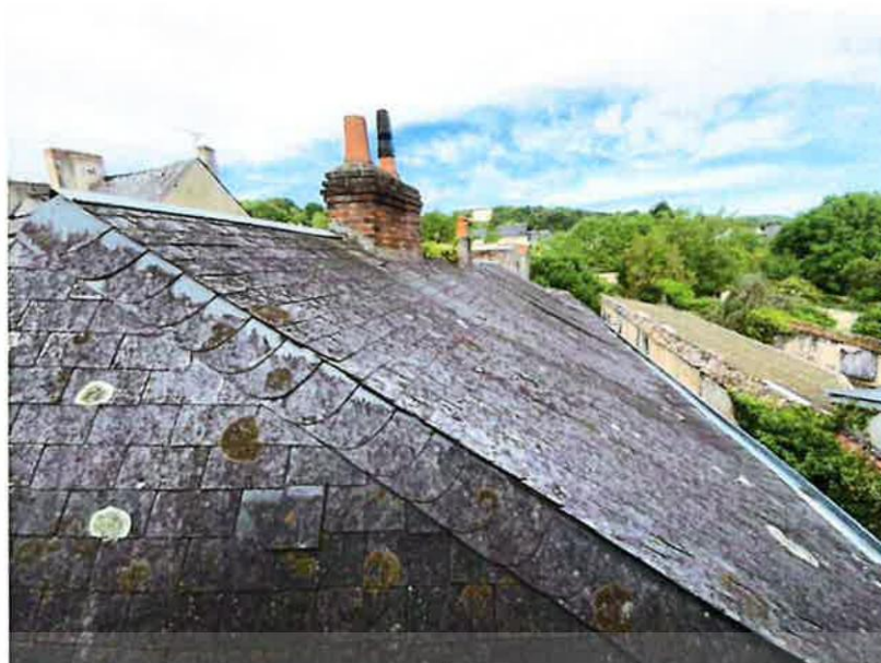
Photographie n°1. Vue sur la toiture de la partie logement du 1 er étage.
