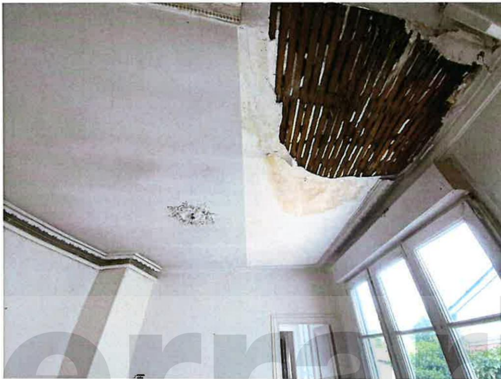
Photographie n°2. À l'aplomb de : soit la noue soit la pièce d'eau
