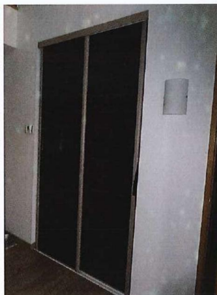
Le pan de mur de droite accueille un placard encastré ouvrant à deux portes coulissantes vitrées opaques, fixées sur rails métalliques.
