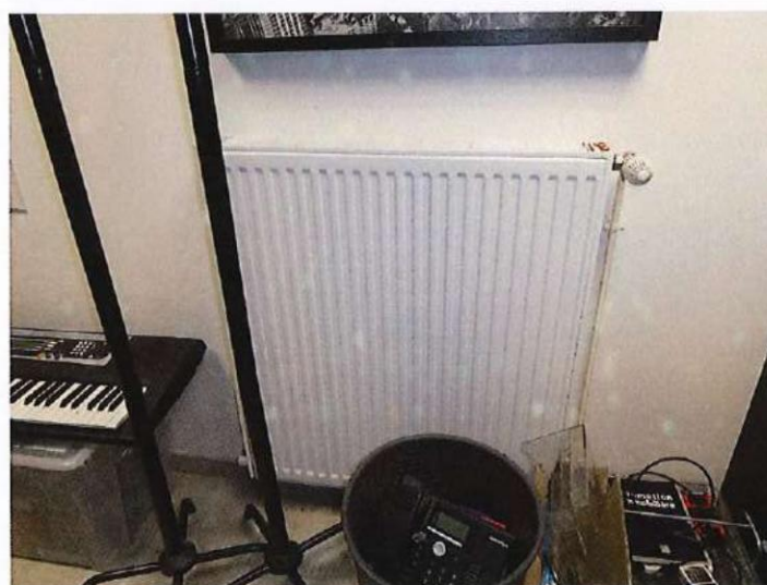
Un radiateur métallique recouvert de peinture, avec robinet thermostatique.
